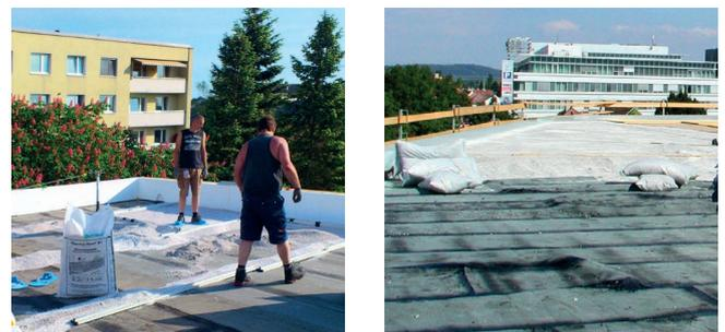
Aufschütten - Abziehen - Verdichten → FERTIG!
