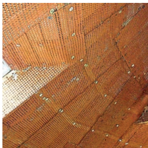
Stauss® Innenausbau Sanierung / Renovierung
