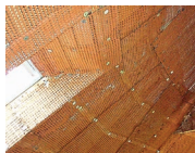
Dachgeschoss diffusionsoffener Ausbau
