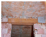
Verkleiden Stahlträger und Holzbalken
