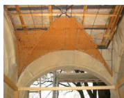
Sanieren auch auf feuchtem Grund
